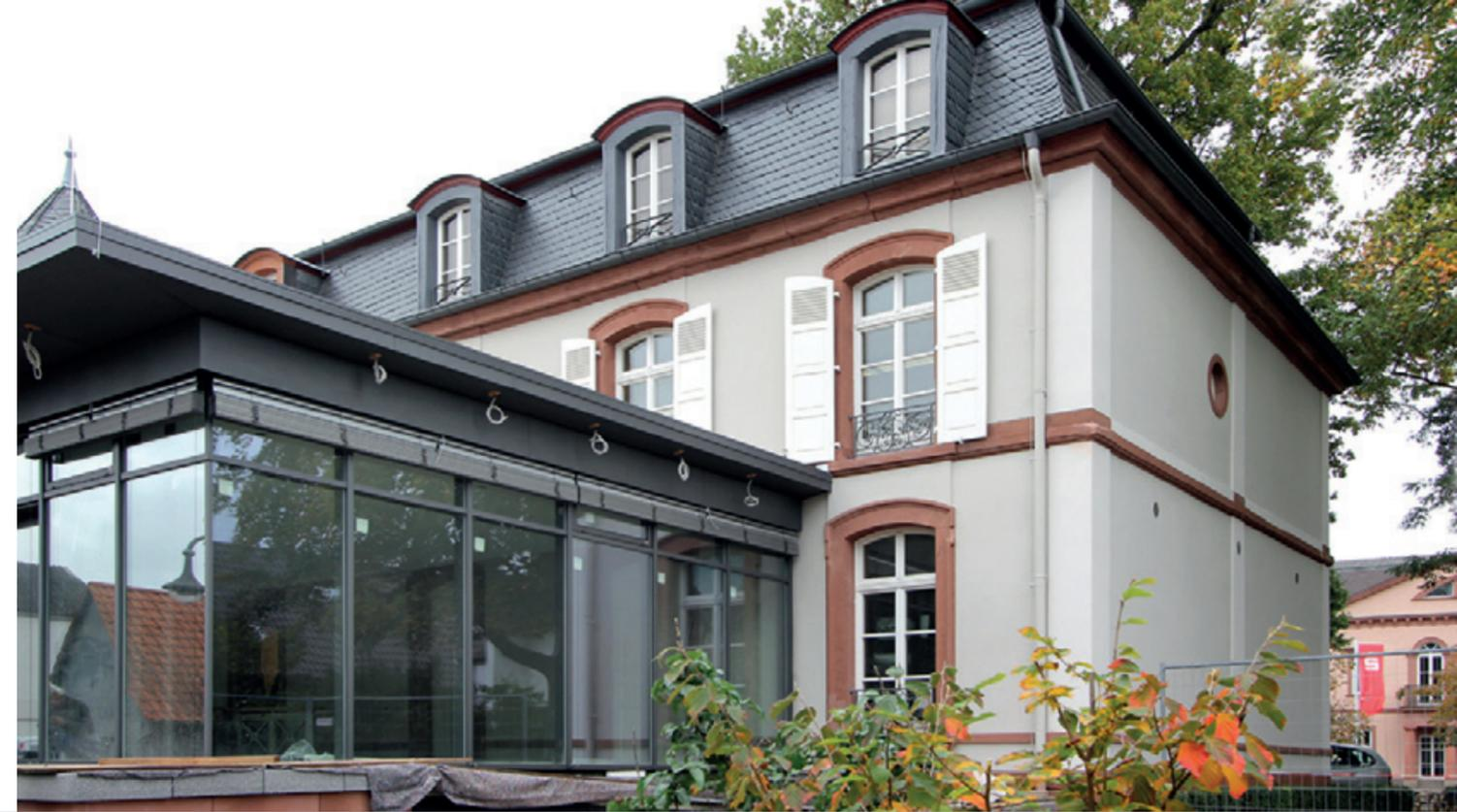
Die Erweiterung erfolgte in Massivbauweise mit einer Natur-Sandstein-Sockelverkleidung mit anschließender gedämmter Putzfassade.
